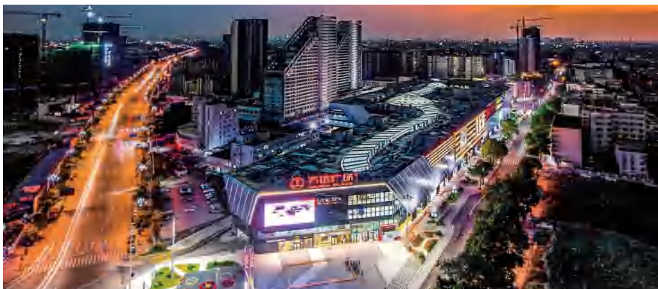
成都青白江万达广场商业综合体
