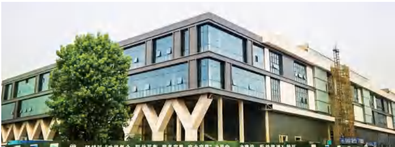
2020年5月15日，成都国际铁路港综保区获批海关总署统计经济区划代码“5101F961”和“51019961” (区港管委 / 供图)
