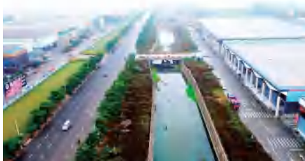
5 月，羊叉河综合整治工程完工（区水务局供图）
