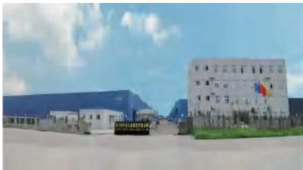
12月2日，青白江区中外运、丰科公司入选成都市现代供应链体系建设支持项目（区国贸和物流局供图）
