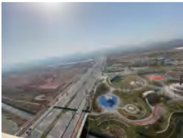
改扩建后的清泉大道欧洲产业城段（区交通局供图）
