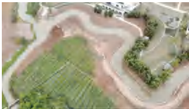
桤木河流域综合整治工程（区水务局供图）
