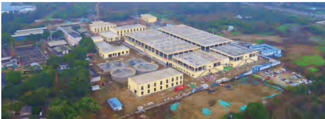
青白江区实施自来水厂扩建工程
