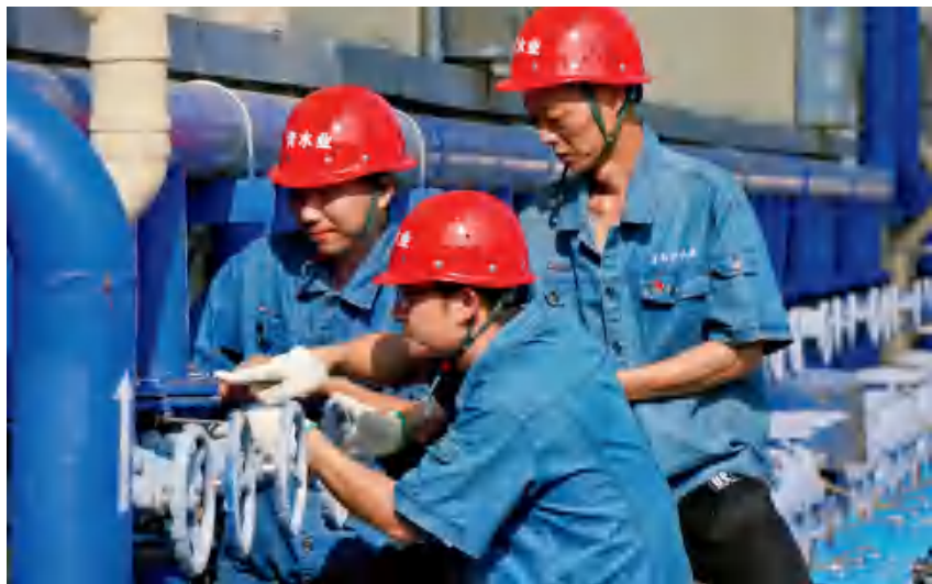
图 150 8 月 19 日，区水业公司进行给水管道维修
