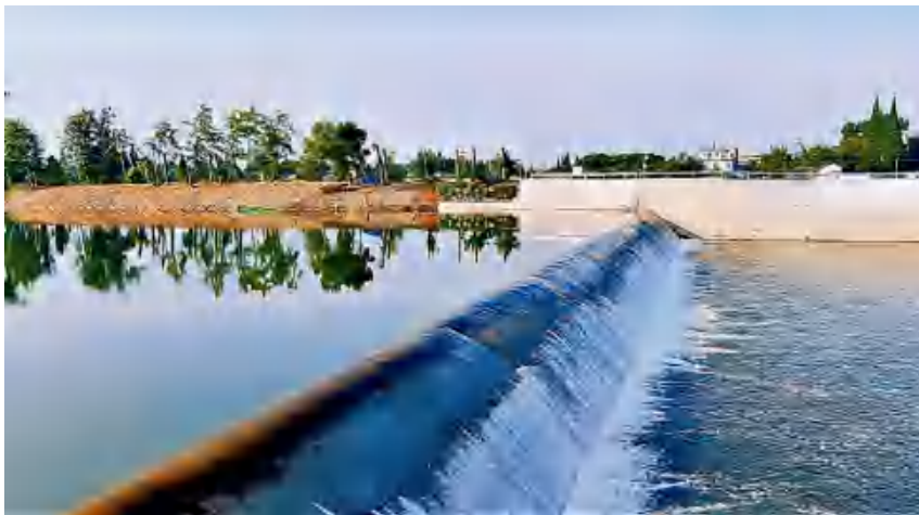
图120 12月，青白江大河马棚堰枢纽综合整治工程完工 (区水务局 供图)
